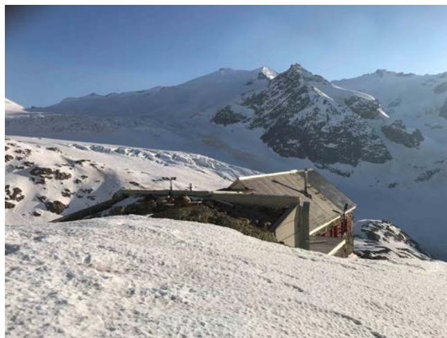
Abbildung: Lawinenzerstörte Trifthütte SAC, rechts unten neuer Standort Foto © Hanspeter Bürgi, 26.03.22
