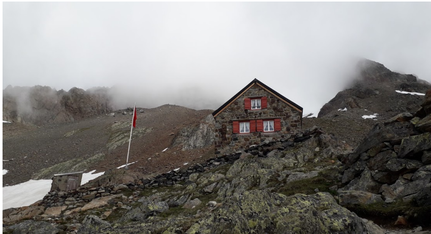
Abbildung 5: Triflhütte vom Hüttenzustieg eigene Aufnahme
