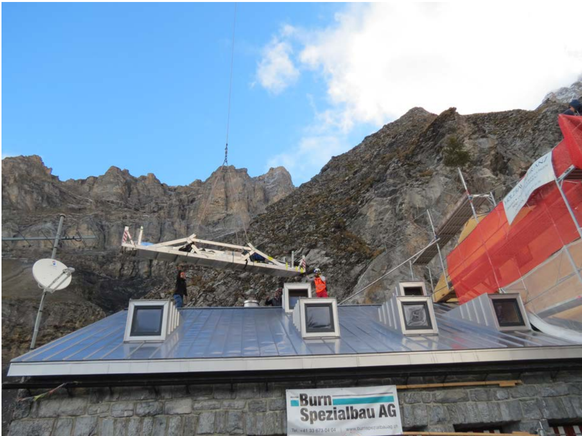
Die Alubleche werden direkt auf dem Dach abgeladen
